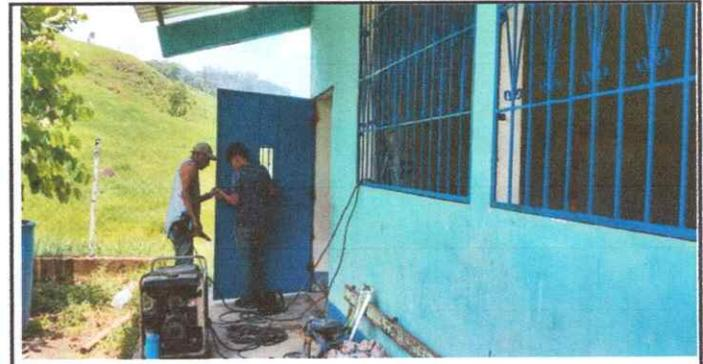
Foto 12: SUSTITUCIÓN DE PUERTAS DE METAL
