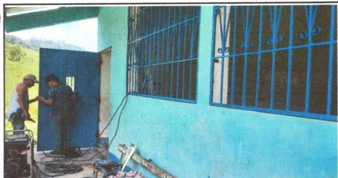
Foto 11: SUSTITUCIÓN DE BALCONES DE METAL
