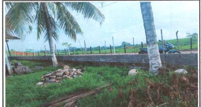
Foto 10: REPARACIÓN DE MURO PERIMETRAL DE BLOCK CON TUBO HG Y MALLA GALVANIZADA
