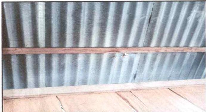
Foto 9: SUSTITUCIÓN DE LÁMINA, POR LÁMINA TROQUELADA ALUZINC CALIBRE 26 PIES
