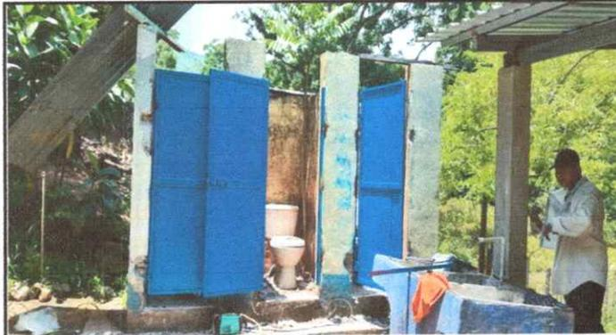
Foto7: MANTENIMIENTO A ESTRUCTURA (LIJADO, CAMBIO DE TUBO, CEPILLADO, SUJECIONES, APLICACIÓN DE PINTURA) A PUERTA DE SERVICIOS SANITARIOS
