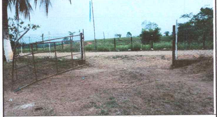
Foto 2: MANTENIMIENTO A PORTONES DE METAL
