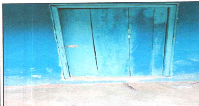
Foto 5: SUSTITUCIÓN DE PUERTAS
