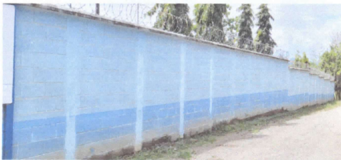
pintar tapial por fuera y por dentro
