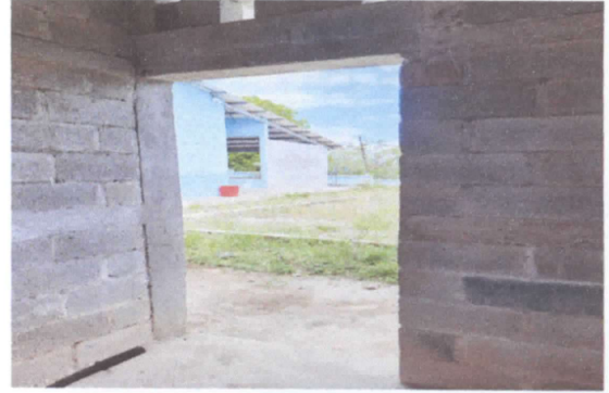
sustitucion de puertas
