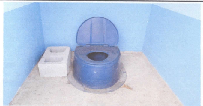
sustitucion de inodoro
