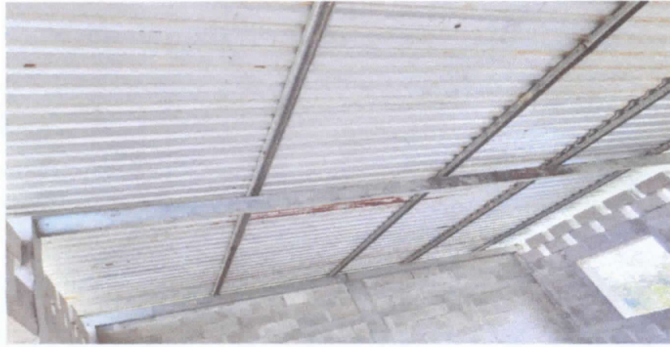
sustitucion de lamina por lamina troquelada aluzinc
