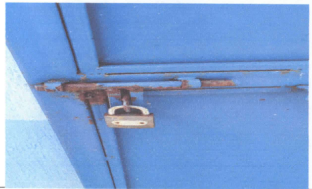
sustitucion de puertas
