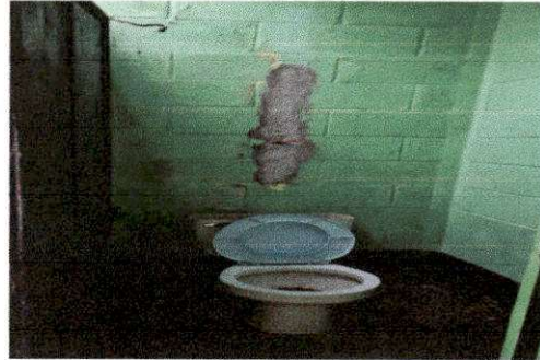
Foto 8 MODULO "A" SERVICIO SANITARIO REMOZAMIENTO DE BAÑOS
