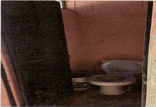
Foto7: .MODULO "A" SERVICIO SANITARIO REMOZAMIENTO DE BAÑOS
