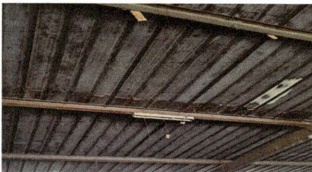
Foto 11:MODULO "B" AULA REMOZAMIENTO DE TECHO SUMINISTRO Y COLOCAION DE LAMINA
