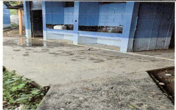
Foto 4: SUMINISTRO E INSTALACION DE PISO TORTA DE CONCRETO
