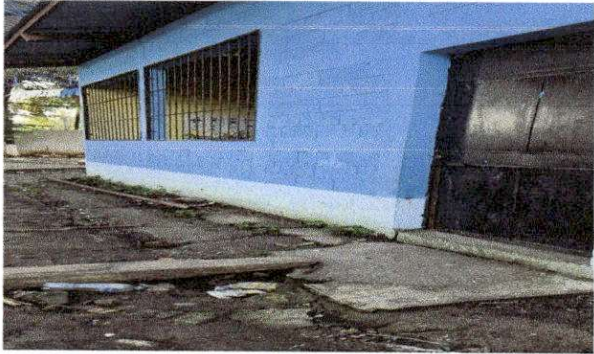
Foto 3: SUMINISTRO E INSTALACION DE PISO TORTA DE CONCRETO
