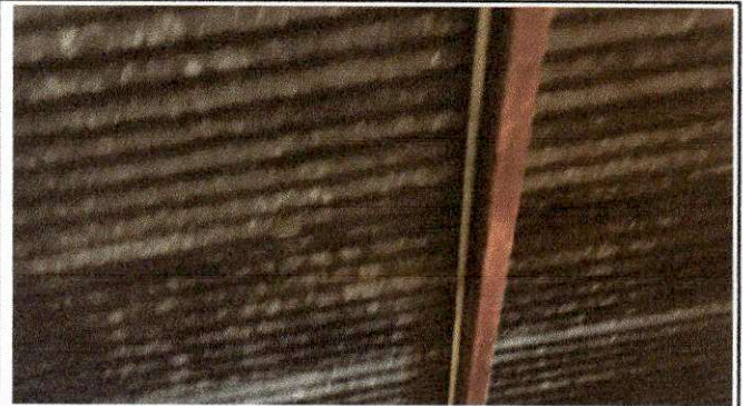
Foto 10 MODULO "B" AULA REMOZAMIENTO DE TECHO SUMINISTRO Y COLOCAION DE LAMINA
