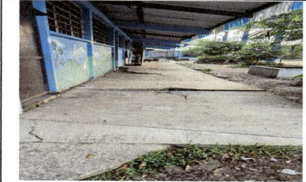
Foto 2: SUMINISTRO E INSTALACION DE PISO TORTA DE CONCRETO
