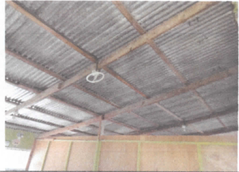
sustitución de estructura
