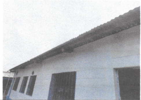
sustitución de canales
