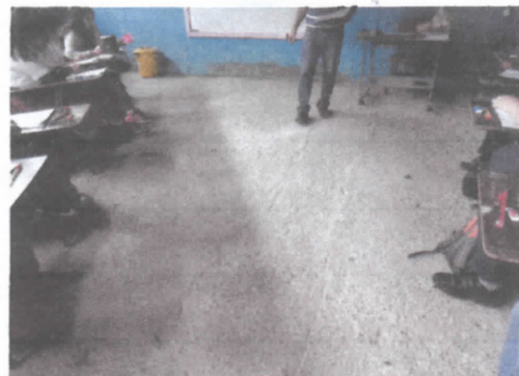
reparación de piso de concreto
