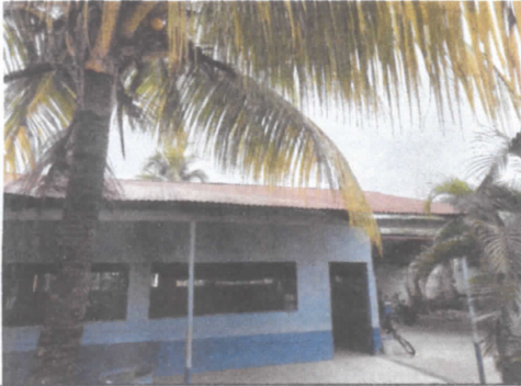
sustitución de láminas
