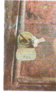
Foto 2: CAMBIO DE DOS CHAPAS
