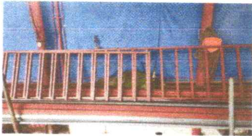
Foto 3: MANTENIMIENTO DE ESTRUCTURA DE VENTANA DE METAL
