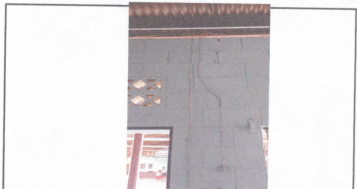
Foto 8. Sustrucción de interruptores dobles.
