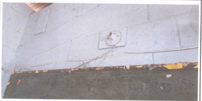
Foto 9. Sustrucción de plafoneras y focos ahorradores.
