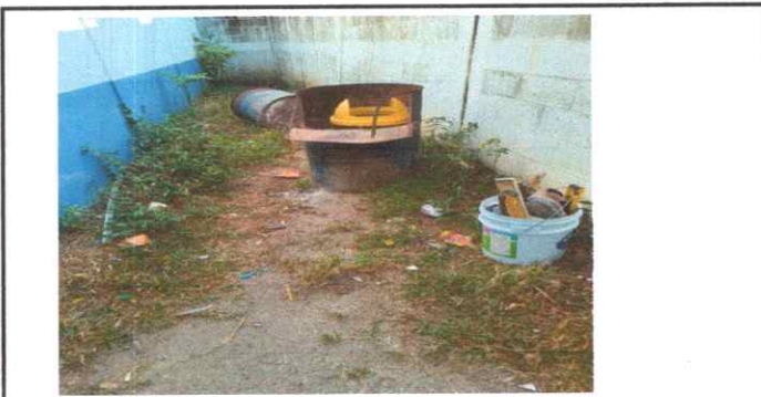
REMOZAMIENTO DE ÁREA DE COCINA
