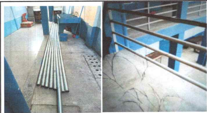
MATERIAL PARA REFORZAR BARANDAL
