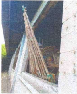
REMOZAMIENTO DE COCINA
