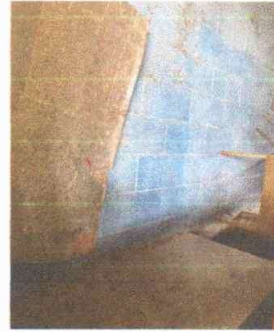
REMOZAMIENTO DE COCINA
