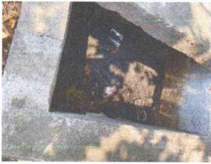
MANTENIMIENTO DE FOSA SEPTICA
