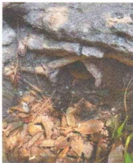
REPARACION DE DRENAJE
