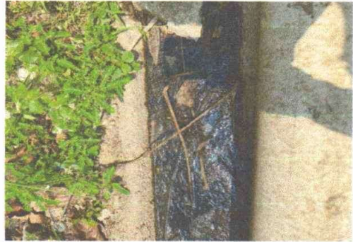
LIMPIEZA DE DRENAJES GENERALES
