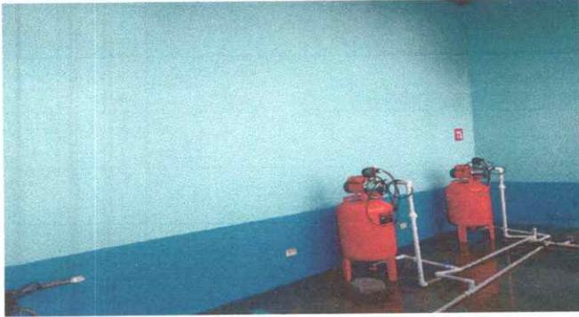
FOTO 1: SUSTITUCIÓN DE BOMBAS NEUMÁTICAS
