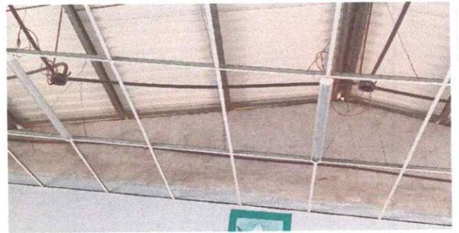
FOTO 4: SUSTITUCIÓN DE MADERA POR COSTANERAS
