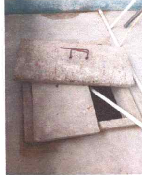
FOTO 2: MANTENIMIENTO DE CISTERNA
