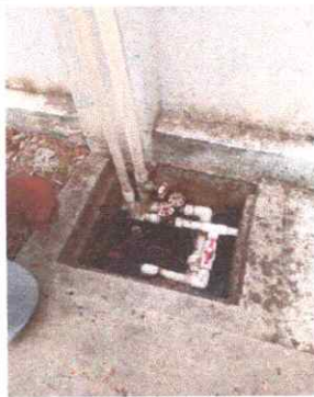
FOTO 3: SUSTITUCIÓN DE TUBERIA DE AGUA POTABLE
