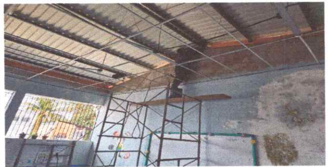
FOTO 4: SUSTITUCIÓN DE MADERA POR COSTANERAS
