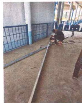
FOTO 6: COLOCACIÓN DE SOLDADURA DE COSTANERAS
