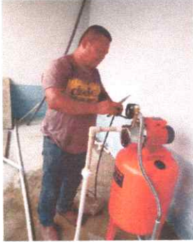
FOTO 1: SUSTITUCIÓN DE BOMBAS NEUMÁTICAS
