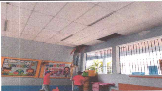
FOTO 5: REMOZAMIENTO DE CIELO FALSO
