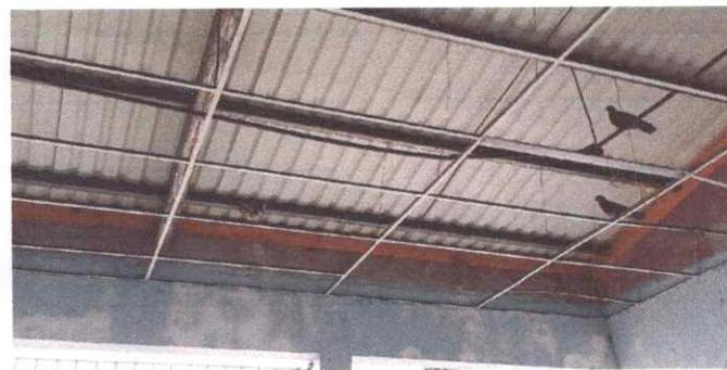
FOTO 6: COLOCACIÓN Y SOLDADURA DE COSTANERAS
