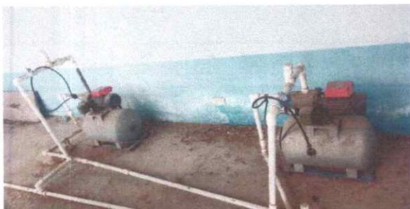
FOTO 1: SUSTITUCIÓN DE BOMBAS NEUMÁTICAS
