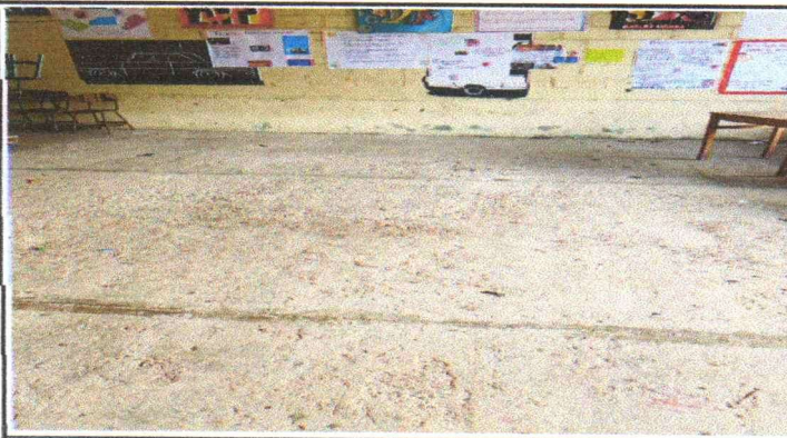
Foto 3 sustitucion de piso de torta por piso de granito
