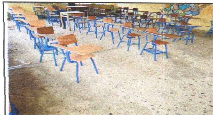
Foto 4 Sustitucion de piso de torta por piso de granito
