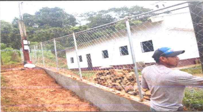
Foto 3: REPARACION DE MURO PERIMETRAL DE BLOCK
