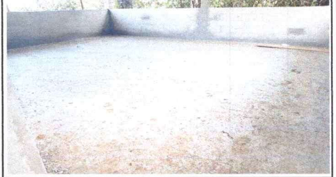
Foto 2: SUSTITUCION DE PISO DE TORTA DE CONCRETO
