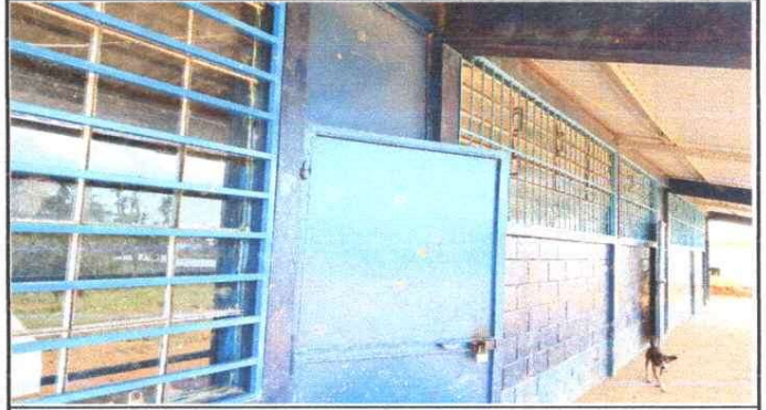
SUSTITUCION DE BALCONES DE METAL
