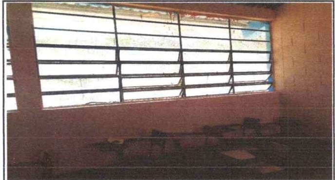
SUSTITUCION DE BALCONES DE METAL
