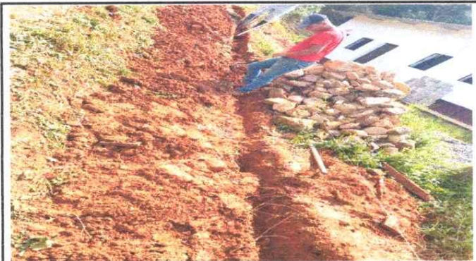
Foto 3: REPARACION DE MURO PERIMETRAL DE BLOCK
