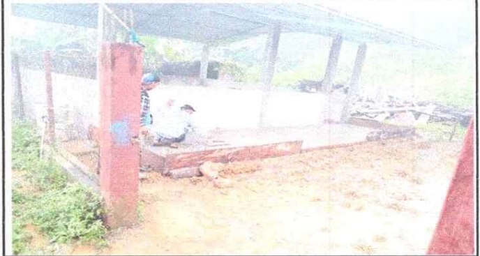
Foto 2: SUSTITUCION DE PISO DE TORTA DE CONCRETO
