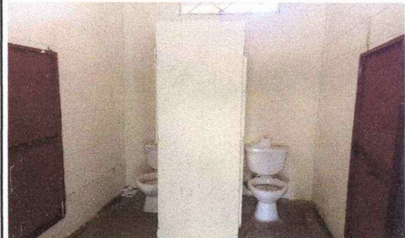
Foto 2: SUSTITUCIÓN DE INODOROS
