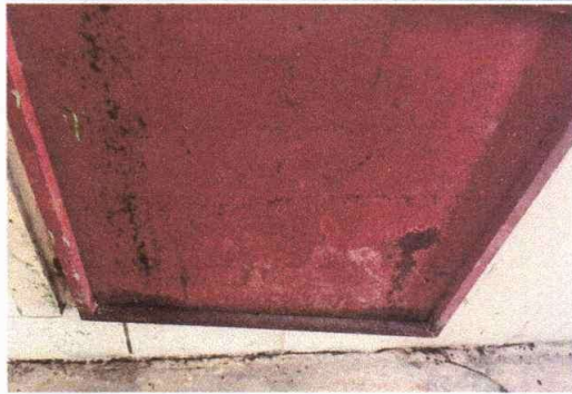
Foto 3: SUSTITUCIÓN DE PUERTA
