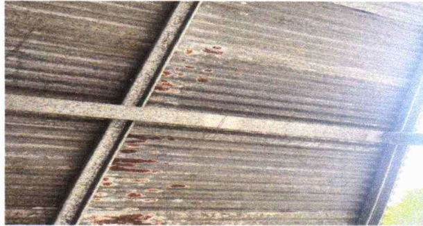
Foto1: SUSTITUCIÓN DE LÁMINA
