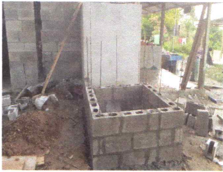
Foto 1: Sustrucion de pila
