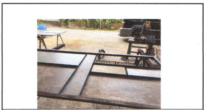
Foto 6: Sustitucion de puerta de madera por matal
