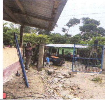
Foto 2: Sustrucion de porton
