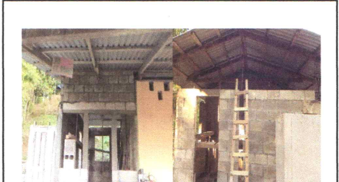
Foto 2: Remozamiento de pared
