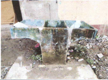
Foto1: Sustitucion de Pila
