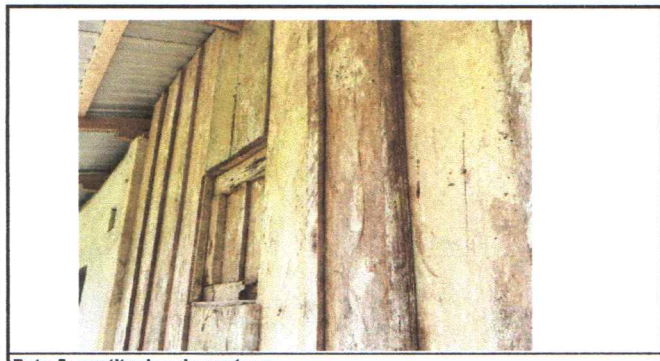
Foto 5: sustitucion de ventana
