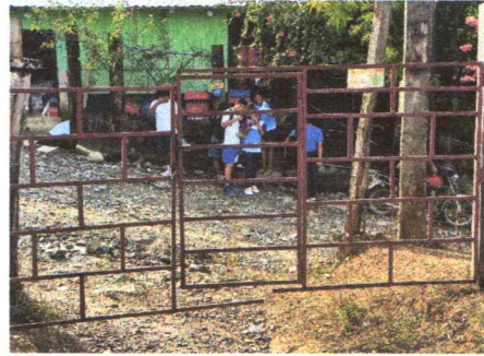
Foto 2: Sustitucion de porton
