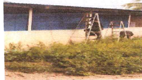
Foto 4: Mantenimiento a balcones de metal
