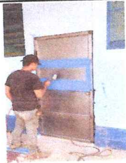
Foto 5: Sustitución de puerta de aula
