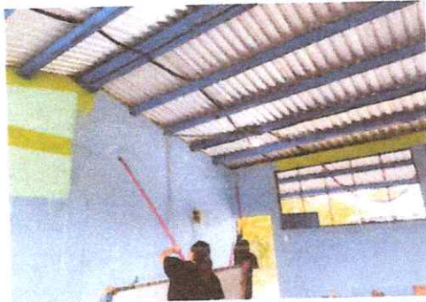
Foto 3: Pintura en muros exteriores e interiores
