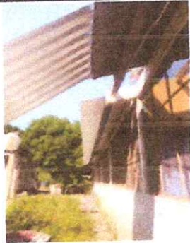
Foto1: Sustitución de lámina, por lámina troquelada aluzinc calibre 26
