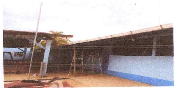
Foto 2: Sustitución de canal de pvc
