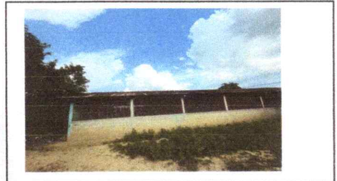
Foto 4: Mantenimiento a balcones de metal
