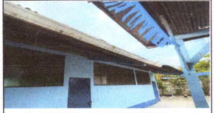
Foto 2: Sustrucción de canal de pvc
