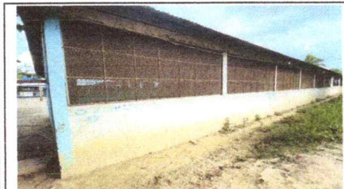
Foto 3: Pintura en muros exteriores e interiores
