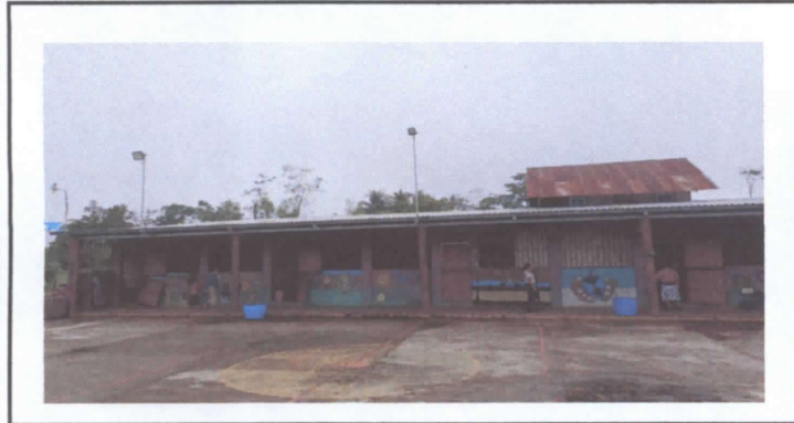
1. Mantenimiento de Techo
