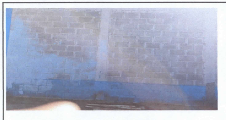
3. Mantenimiento de Pintura en pared exterior y interior
