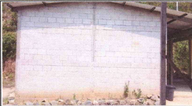
Foto 3: REPELLO DE MUROS
