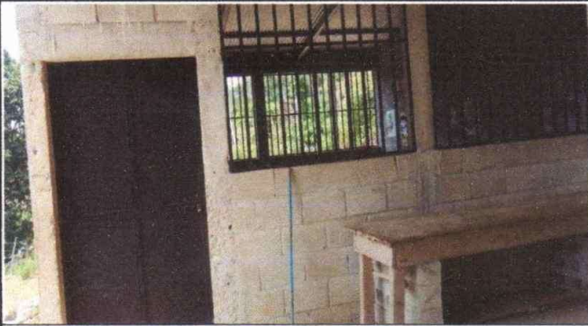
Foto 1: PINTURA DE MUROS EXTERIORES E INTERIORES
