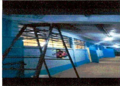
Foto 4: Reparación de sistema eléctrico
