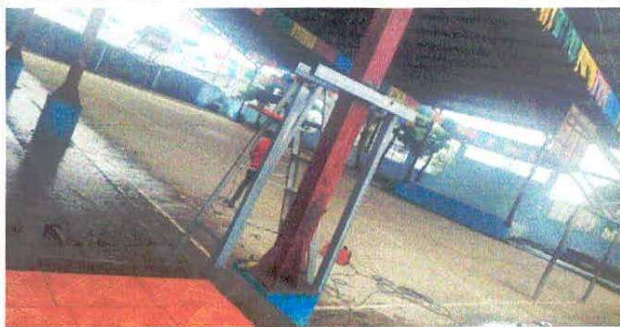
Foto 5: Reparación de cableado Electrico
