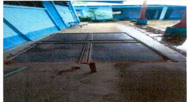
Foto 2: Sustitución de puertas
