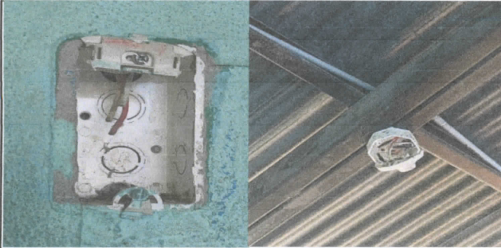
Sustitución de plafoneras, lámparas, toma corrientes dobles y cableado eléctrico.
