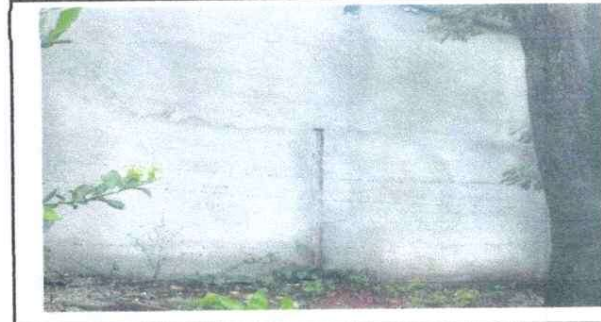
Foto 14: Remozamiento de pared
