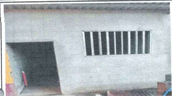
Foto 11: Fabricación e instalación de ventana-balcon de metal
