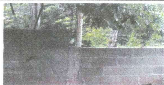
Foto 10: Remozamiento de pared
