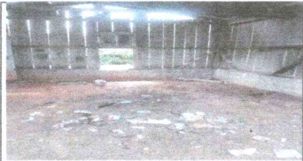
Foto 3: Sustitución de piso de torta de concreto
