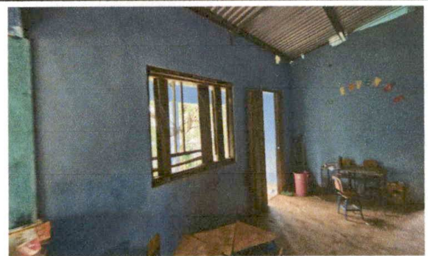
Foto 10 SUMINISTRO E INSTALACION DE VENTANAS DE PVC
