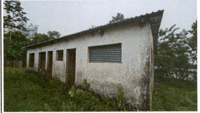
Foto 2: SUMINISTRO E INSTALACION DE VENTANAS DE PVC
