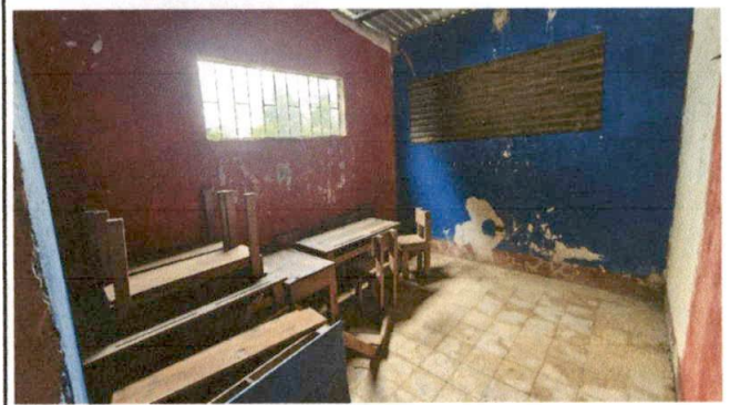
Foto 8: SUMINISTRO E INSTALACION DE VENTANAS DE PVC
