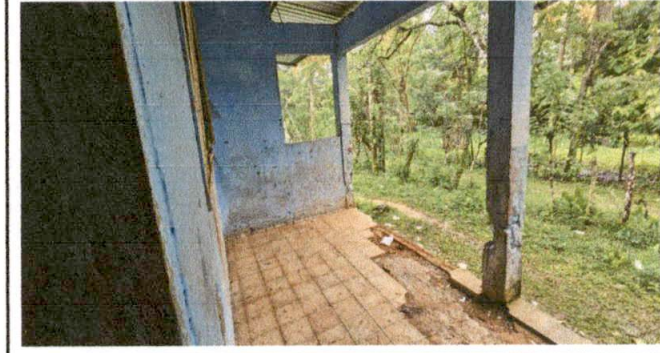
Foto 6: SUMINISTRO Y APLICACION DE PINTURA EN MUROS
