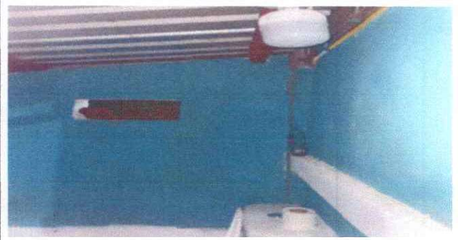
Foto 2: Remozamiento de Techos de 2 sanitarios
