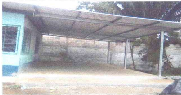
Foto 5: Construcción de galera ambiente para aula
