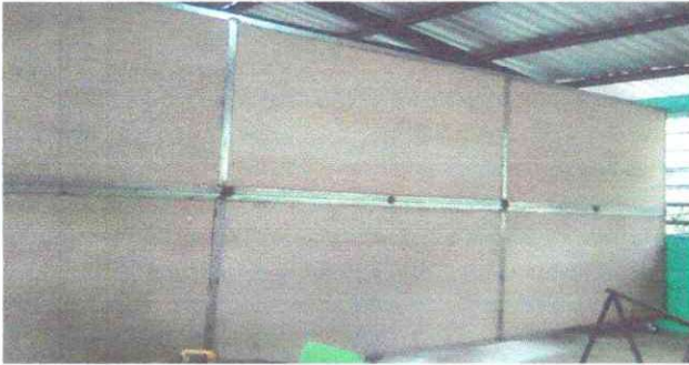
Foto 3: Reparación de 2 canceles de aulas
