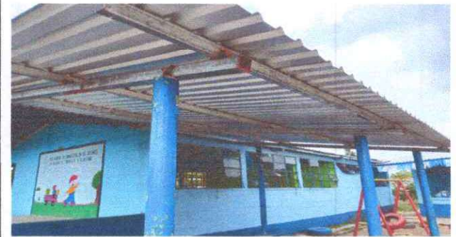
Foto 4: Remozamiento de Techo desayunador.
