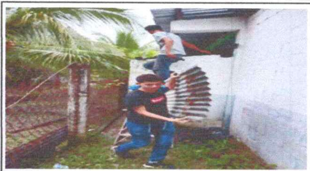
Foto 2: Remozamiento de Techos de 2 sanitarios
