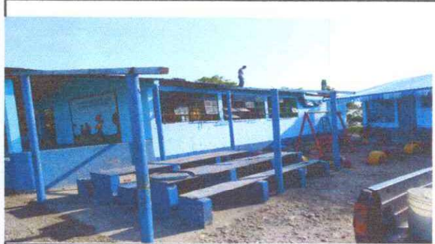
Foto 4: Remozamiento de Techo desayunador.
