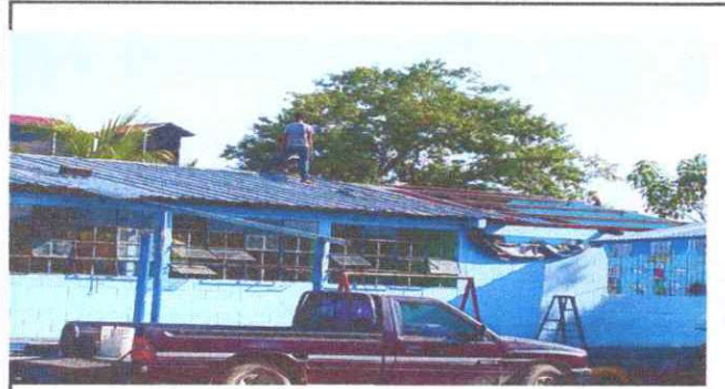
Foto1: Remozamiento de Techos de 2 aulas.
