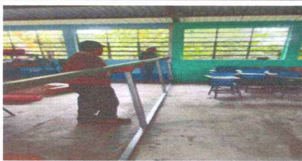
Foto 3: Reparación de 2 cancelos de aulas
