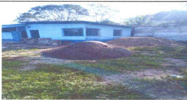
Foto 5: Construcción de galera ambiente para aula
