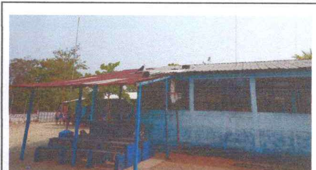
Foto 4: Remozamiento de techo desayunoador
