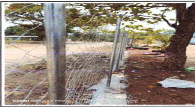
Foto 6: Colocacion de malla con tubos.
