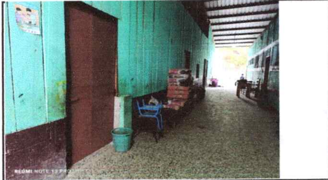
Foto1: puertas nuevas de metal
