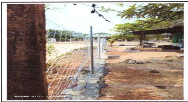
Foto 5: Colocacion de malla con tubos.
