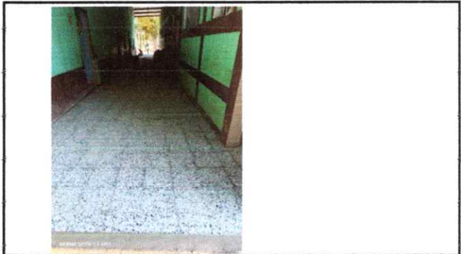
Foto 4 Finalizacion de pasillo
