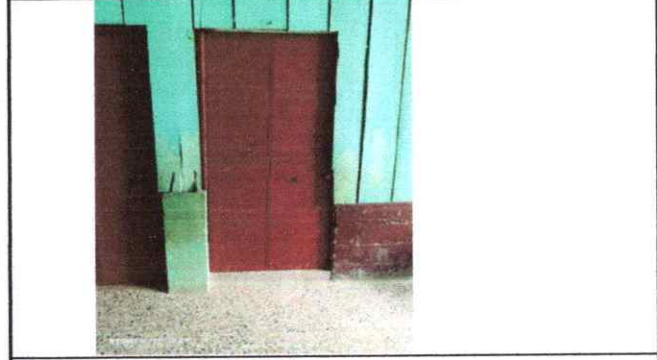
Foto 2: puertas nuevas de metal
