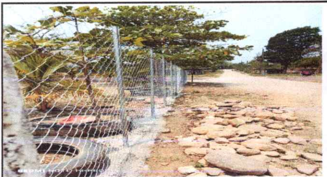
Foto 1: Colocacion de malla con tubos.
