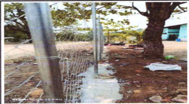
Foto 2: Colocacion de malla con tubos.
