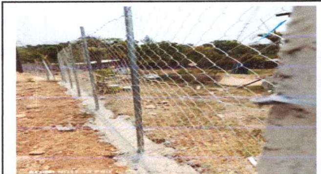
Foto 3: Colocacion de malla con tubos.
