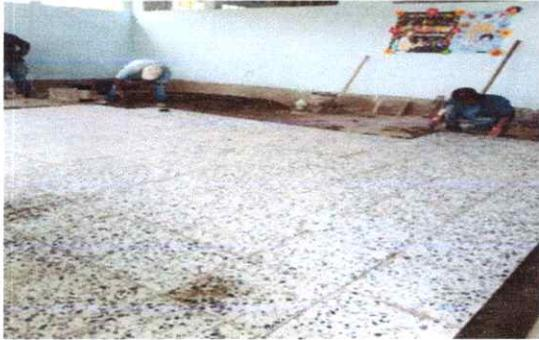
Foto 3: proceso de colocacion de granito
