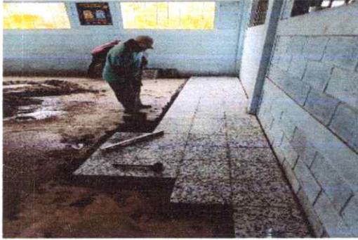
Foto1: proceso de colocacion de granito
