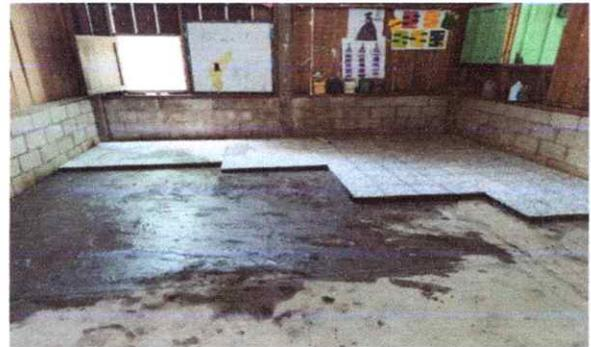
Foto 4: proceso de colocacion de granito
