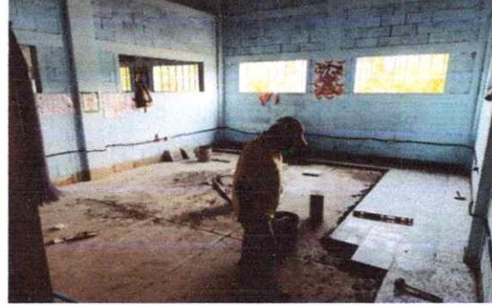
Foto 2: proceso de colocacion de granito
