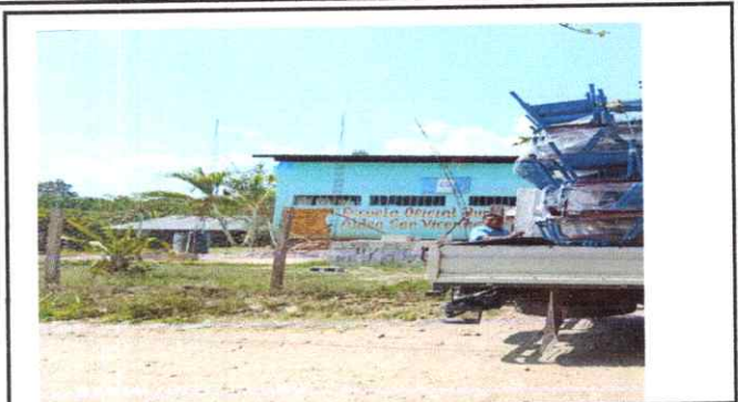
Foto 1: Malla perimetral con poste de madera
