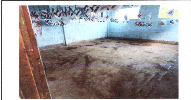
Foto 1: piso antiguo de las aulas
