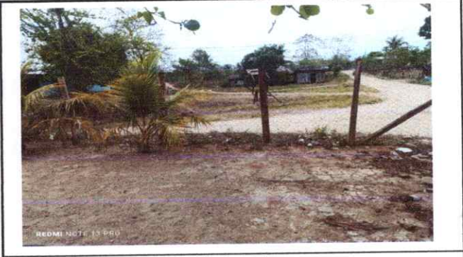
Foto 2: malla perimetral con poste de madera
