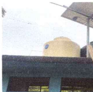
Foto 5: Sustitucion de deposito de agua 1700 LT.
