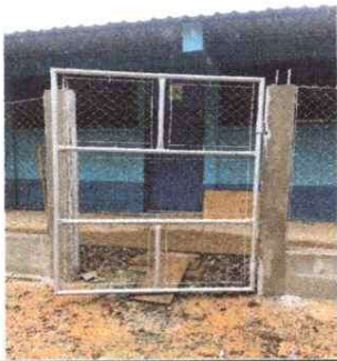
Foto 3: Mantenimiento a portones de metal
