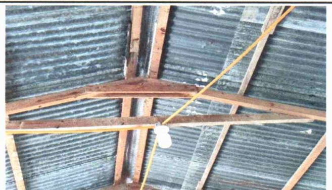
Cambio de estructura de madera por metal y lámina por deterioro y agujeros.
