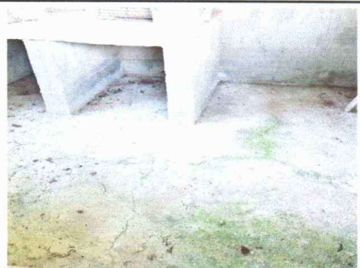
Sustitución de piso de concreto en la cocina.
