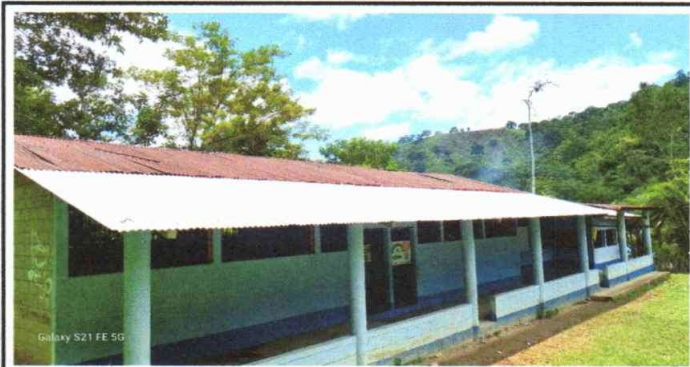
Cambio de lámina por deterioro.
