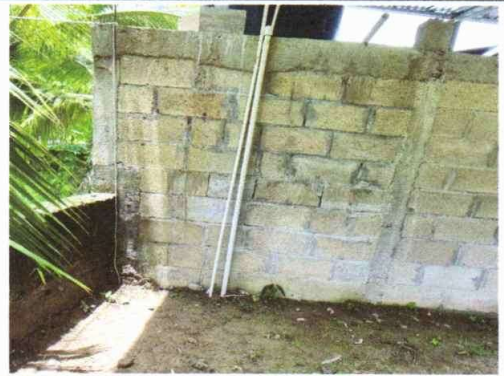
Reparación de muro de contención
