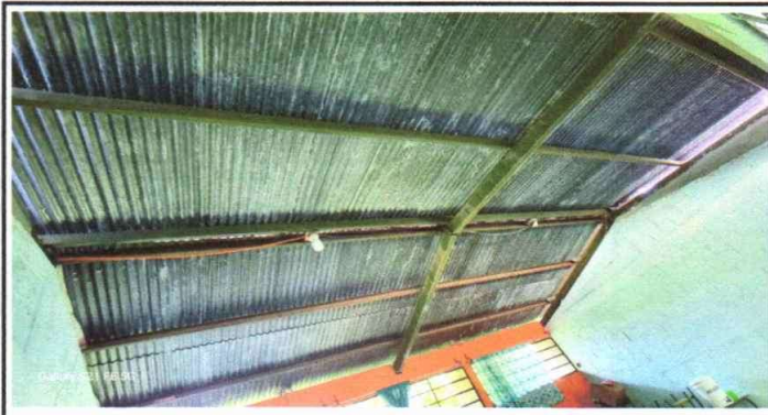
Mantenimiento de soporte de metal y cambio de lámina por deterioro.
