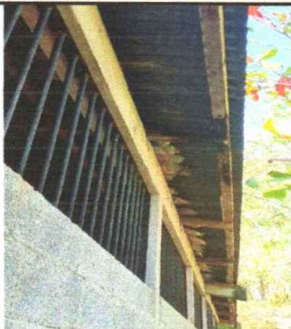
Cambio de estructura de techo de madera a metálica
