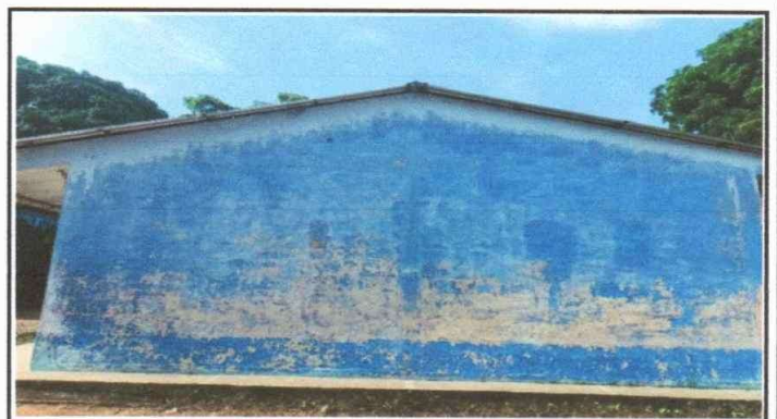
Foto 4: Pintura de Muros exteriores e interiores
