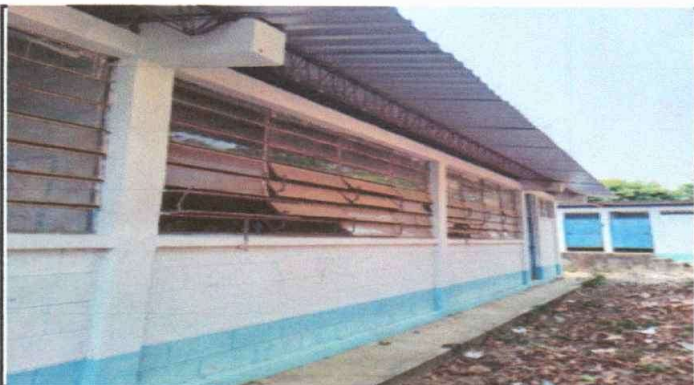
Foto 3: Sustrucción de balcones de metal
