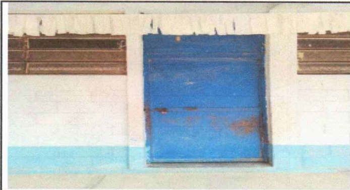
Foto 1: Sustrucción de puertas de metal
