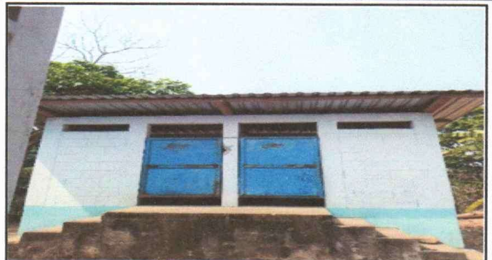
Foto 2: Sustrucción de puertas de servicio sanitario
