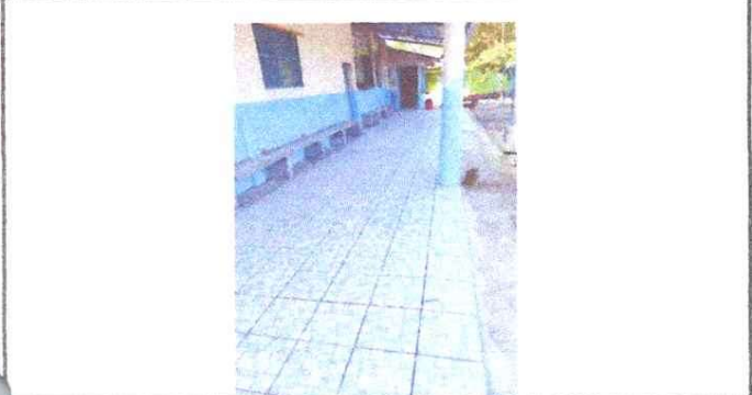
Foto1: colocación de piso ceramico
