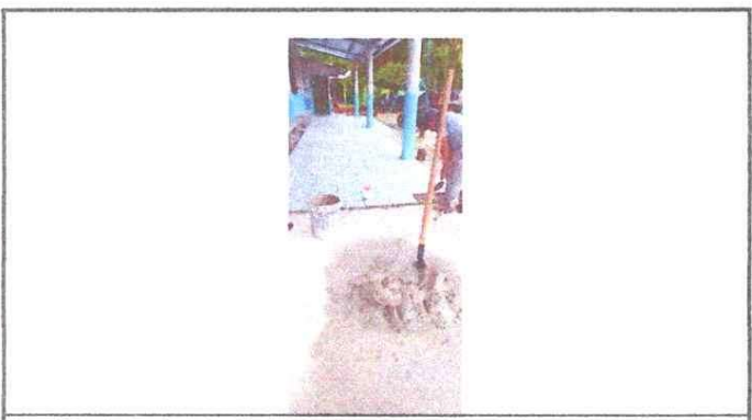
Foto 3: colocacion de piso ceramico
