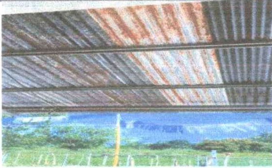
Foto 1: Sustrusion de Lámina de corredor
