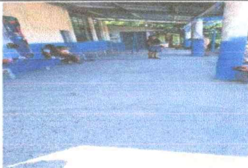
Foto 5: Mantenimiento de Piso de granito
