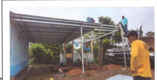
Foto 9: Sustitución de lámina, por lámina troquelada aluzinc calibre 26
