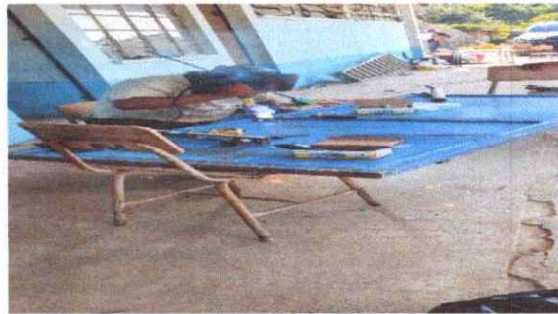
Foto 16: sustitución de chapa
