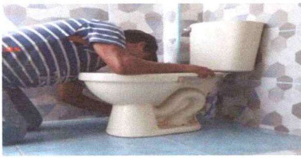
Foto 15: Sustitución de inodoro
