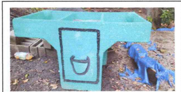
Foto 14: Sustitución de pila de cemento de dos lavaderos
