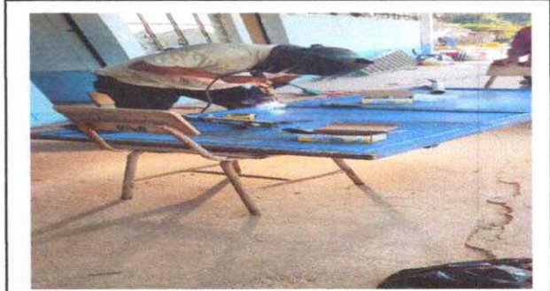
Foto 12: Sustitución de puerta
