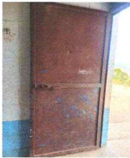
Foto 3: Mantenimiento a estructura (lijado, cambio de tubo, cepillado, sujeciones, aplicación de pintura) Y sustitución de chapa
