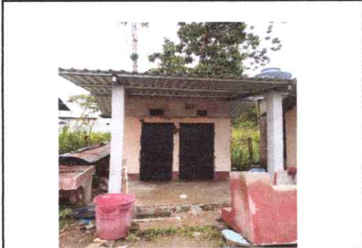
Foto 1: Sustrucción de lamina acanalada por lamina troquelada
