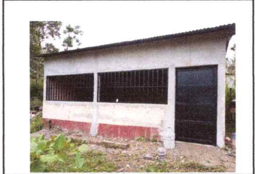
Foto 2: Sustrucción de ventanas
