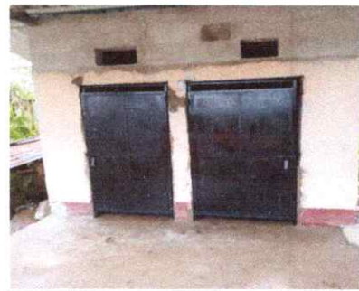
Foto 6: Sustitucion de puertas
