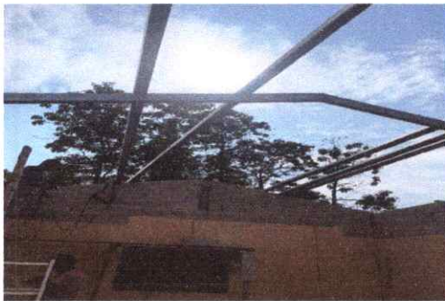
Foto 3: Sustitucion de estructura de madera por metal
