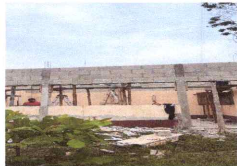
Foto 2: Sustitucion de ventanas
