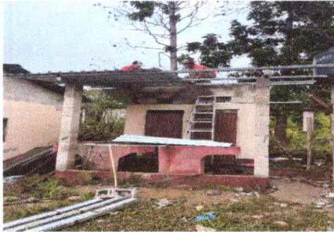
Foto 1: sustitucion de lamina acanalada
