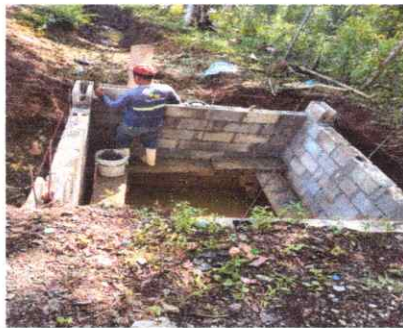
Foto 5: Sustitucion de caja de Registro
