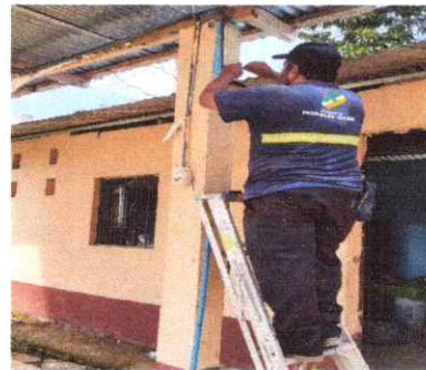
Foto 4: Sustitucion de cableado eléctrico
