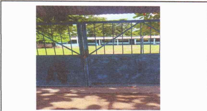
Foto 3: Sustitución de portón de metal
