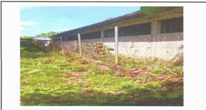
Foto 5: Seguimiento de muro perimetral
