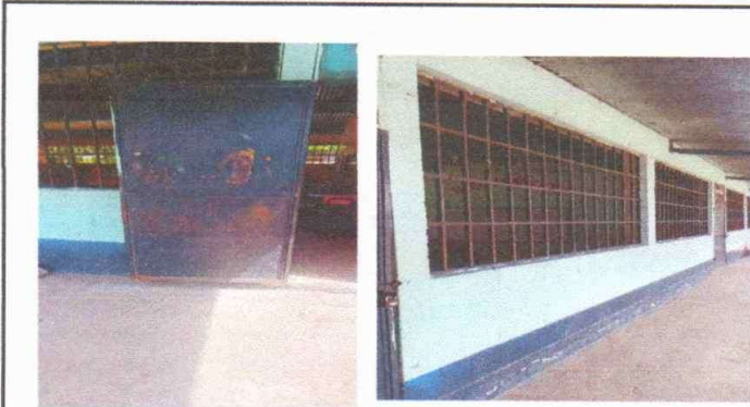
Foto 1: Mantenimiento a estructura (lijado, cambio de tubo , cepillado, sujeciones, aplicación de pintura) Puertas y Balcones
