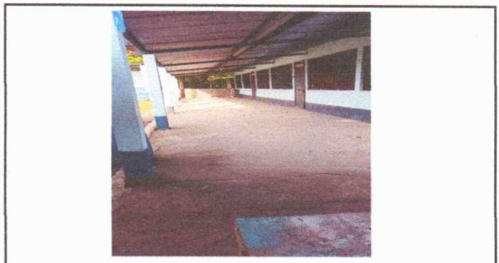
Foto 4: Sustitución de piso cerámico
