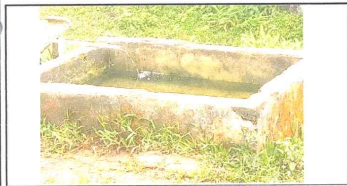
Foto 5: Reparación de pila
