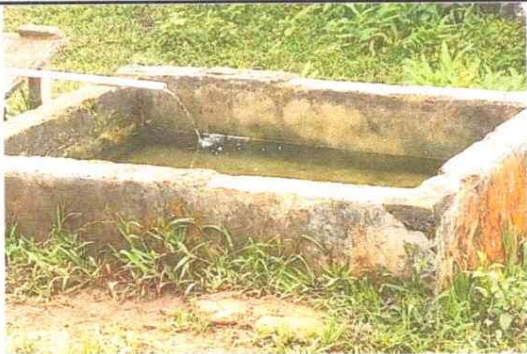
Foto 5: Reparación de pila
