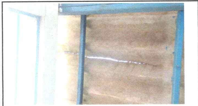
Foto 3: Sustrucción de lámina en máil estado
