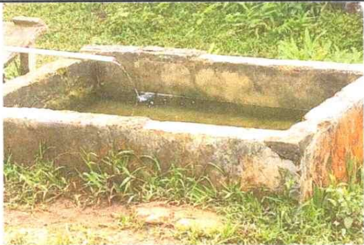
Foto 5: Reparación de pila
