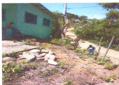
REPARACIÓN DE MALLA Y TUBO HG EN MURO PERIMETRAL
