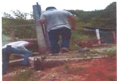
SUSTITUCIÓN DE PUERTA DE MADERA POR PORTÓN DE METAL
