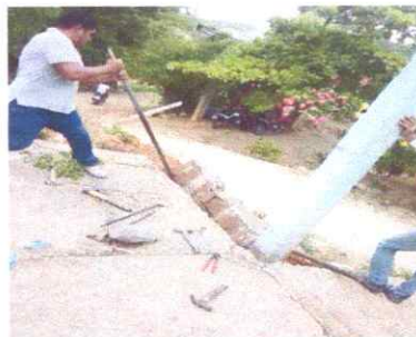
REPARACIÓN DE MURO PERIMETRAL POR BLOCK
