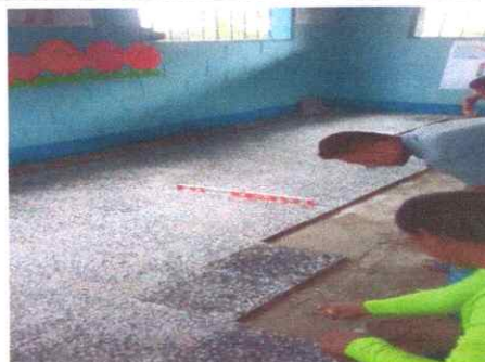
SUSTITUCIÓN DE PISO DE DOS AULAS Y DIRECCIÓN
