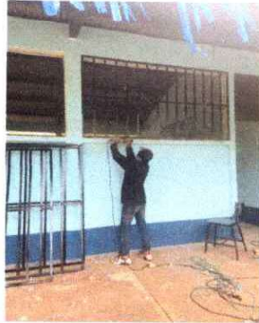
Foto1: Sustitucion de balcones por nuevos
