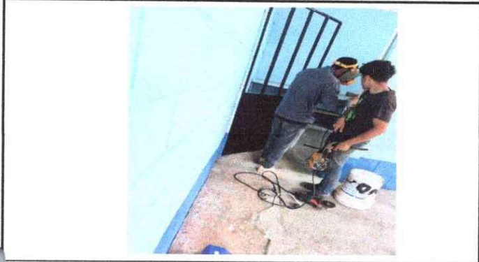
Foto1: Sustitucion de puerta por una nueva
