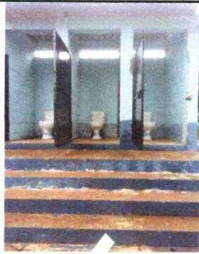
Foto 5: Sustitucion de sanitarios por nuevos
