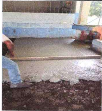
Foto 3: Mantenimiento, torta de concreto nueva
