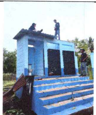
Foto 4: Sustitucion de lamina de los baños
