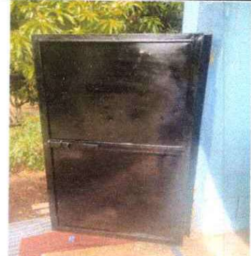
Foto 2: Sustitucion de puertas de baños
