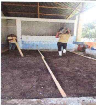
Foto 3: Mantenimiento, torta de concreto nueva
