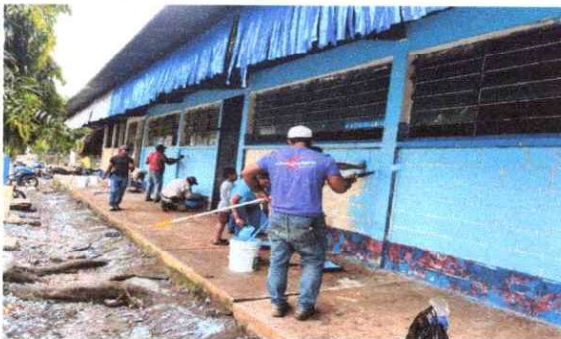
Foto 5: Pintura de Muros exteriores y interiores
