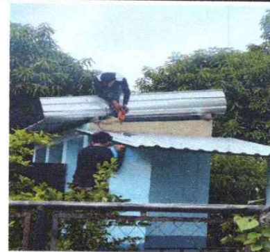
Foto 4: Sustitucion de lamina de los baños
