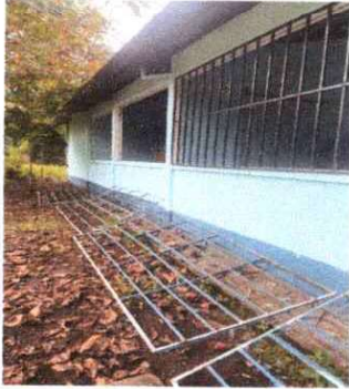
Foto 1: Sustitucion de balcones por nuevos
