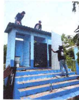
Foto 2: Mantenimiento de puertas de baños
