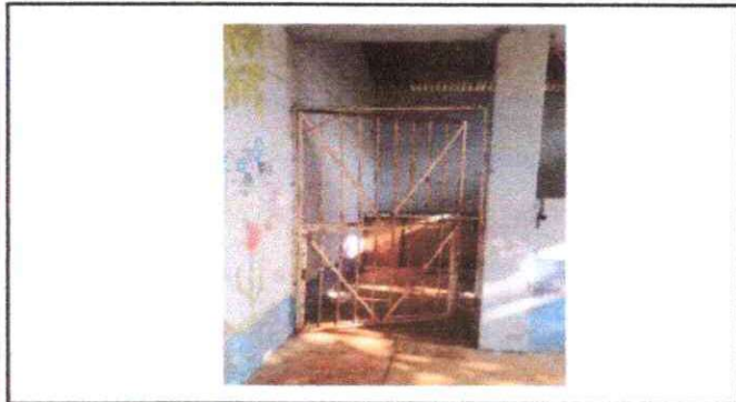
Foto 3: Sustrucción de chapa y Sustrucción de puerta
